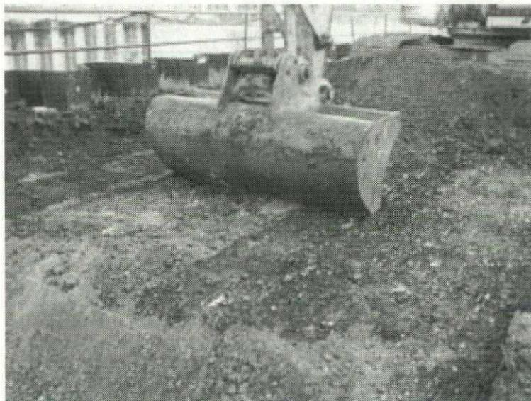
Décapage des niveaux inférieurs. En plus sombre la tranchée de diagnostic. Au-dessus, sable graveleux contre les palplanches de la trémie. Au-dessous, argiles perturbées.
