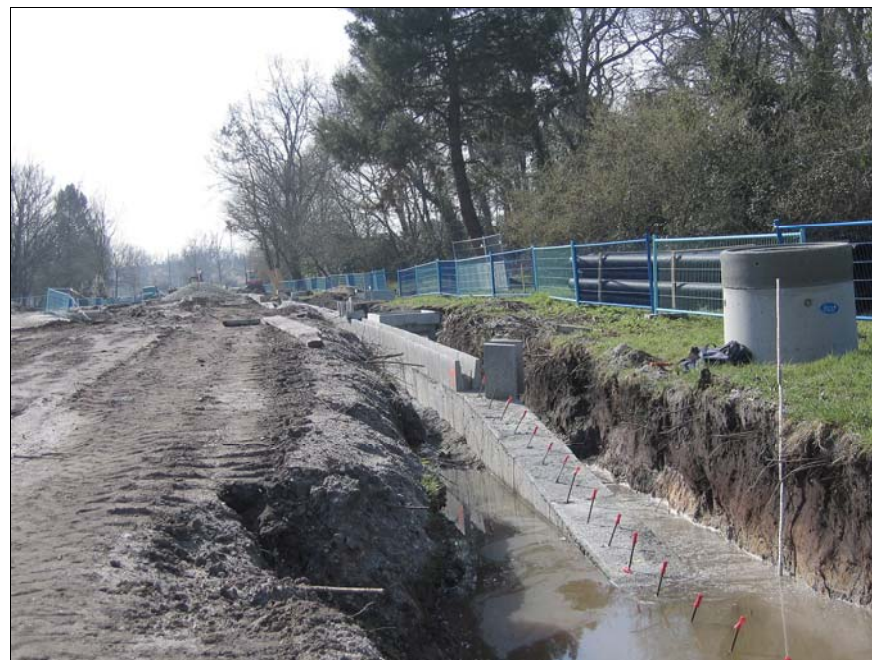
Fig.5, vue générale de la tranchée sud, 06_068_P00049.
