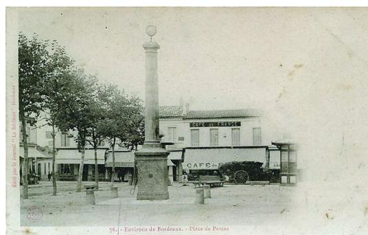
*Puits aménagé en fontaine avec pompe, piédestal et colonne pour alimentation en eau potable*
