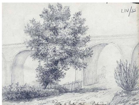
Pour permettre la mise hors d'eau de cette voie ferrée, un viaduc sera construit immortalisé par M. Dubourdieu en 1845. La maçonnerie du viaduc de Pessac avec ses 91 arches d'une ouverture de 8 mètres sur 960 mètres est menée à son terme en 1841.
